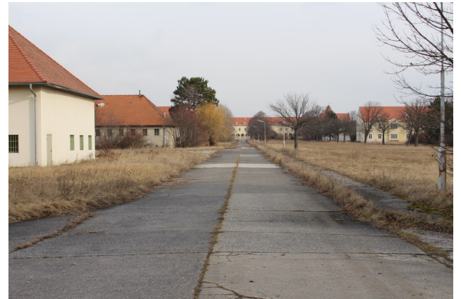
Bild 1: Das Areal der Martinek-Kaserne – denkmalgeschützte Bestandsgebäude mit großen Freiflächen. Foto: Peter Biermayr
